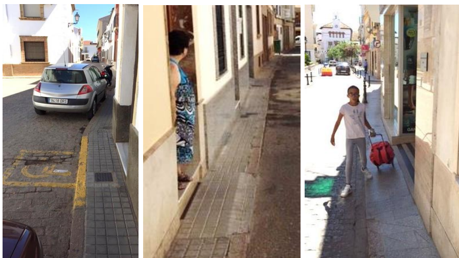
Conflicto entre necesidades de accesibilidad e infraestructura inadecuada.
