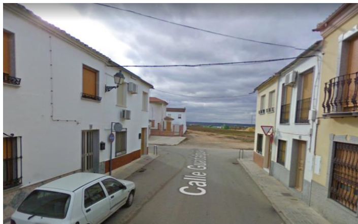
Tramo existente de calle Guadalquivir, se aprecia zona aun sin construir (recuperado de GoogleMaps)
