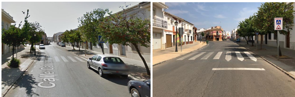
Antes y después en A-420 (Tramo Calle Calvario). Ampliación de calzada. (Recuperado de GoogleMaps y elaboración propia)
